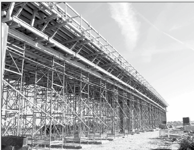
Obiekt WD-14 – budowa S3 Klucz – Gorzów Wlkp.
