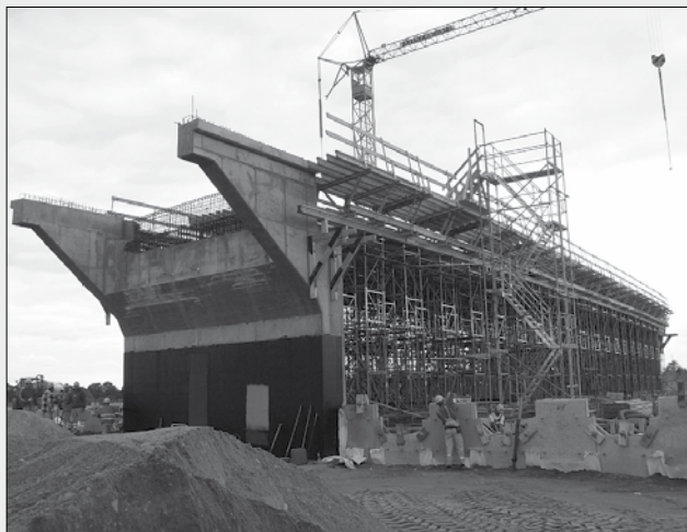
Obiekt WD-51 – budowa S3 Klucz – Gorzów Wlkp.
