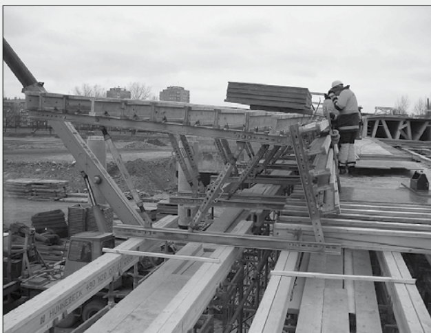
Obiekt RW-4 – budowa DTŚ – Ruda Śląska
