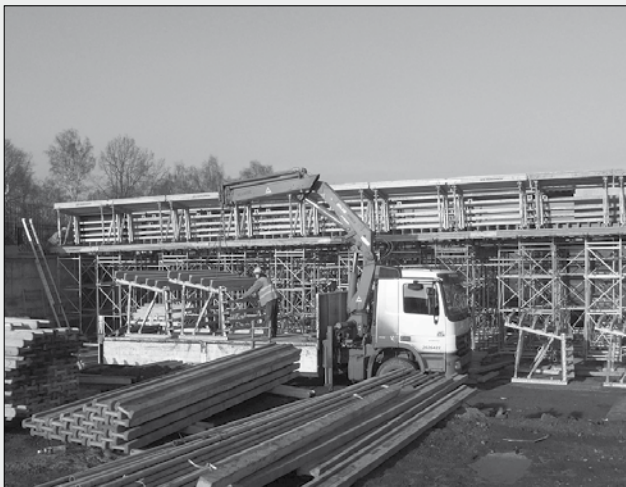
Obiekt WD-490 – budowa Sośnica – Belk
