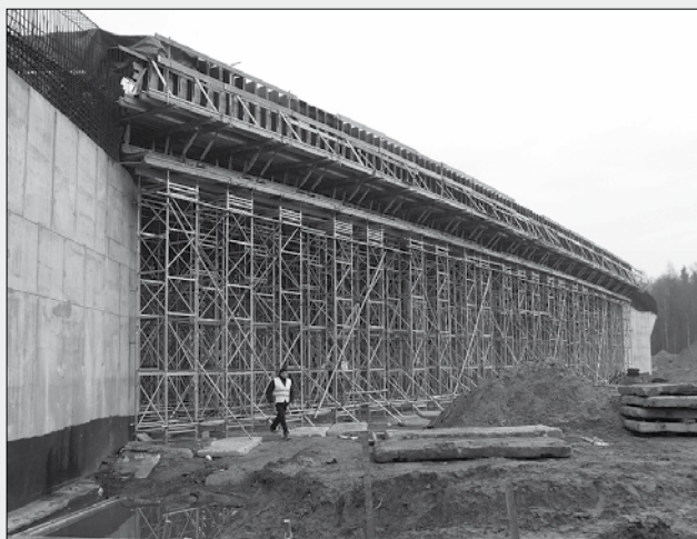
Obiekt PZ-472 – Budowa A1 Sośnica – Bełk
