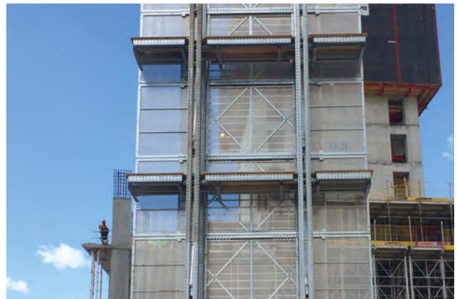
► Schutz mehrerer Etagen durch optionale vertikale Verlängerung
