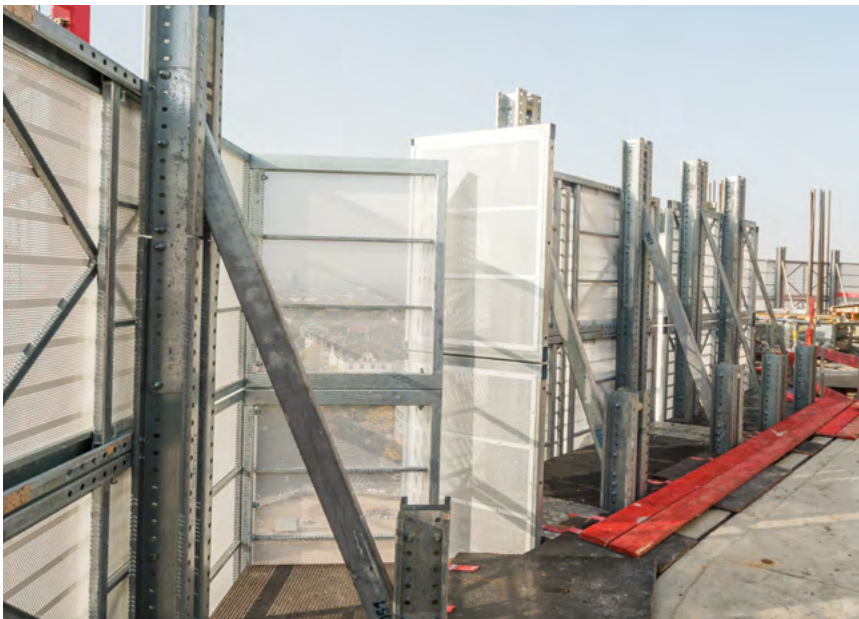
► Mehr Sicherheit auf der Baustelle und für die Öffentlichkeit durch vollständige Umkleidung der Arbeitsumgebung
