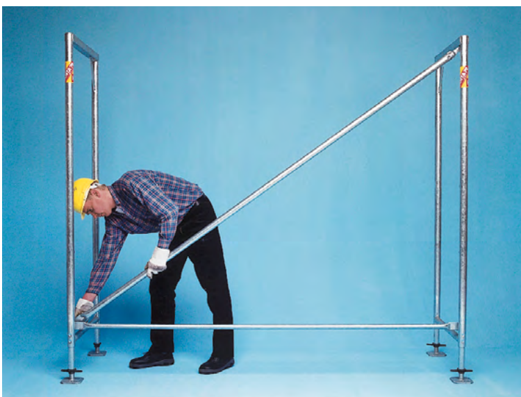
► Sicherer und zwangsläufig lotrechter Aufbau nach Erstellen des ersten Gerüstfeldes
